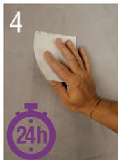
4. Une fois sec (24h\*\* de séchage complet), vous pouvez réaliser un léger ponçage sans forcer.
